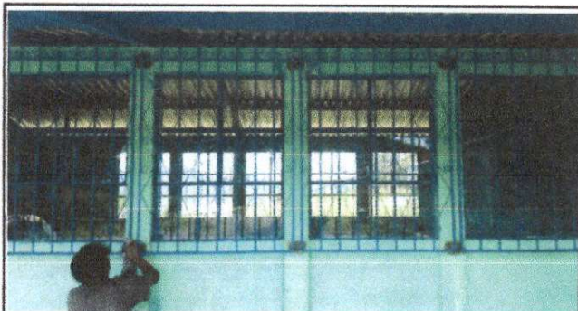
Foto 3: SUSTITUCION DE VIDRIOS.
