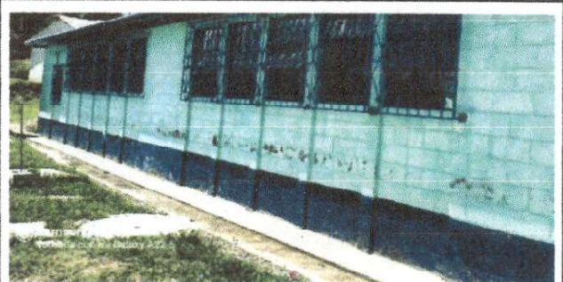
Foto 5: SUSTITUCION DE TORTA DE CONCRETO.
