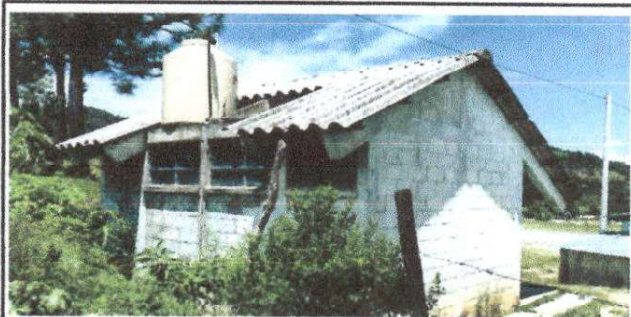
Foto 6: SUSTITUCION DE DEPOSITO DE AGUA DE 1000 LT.
