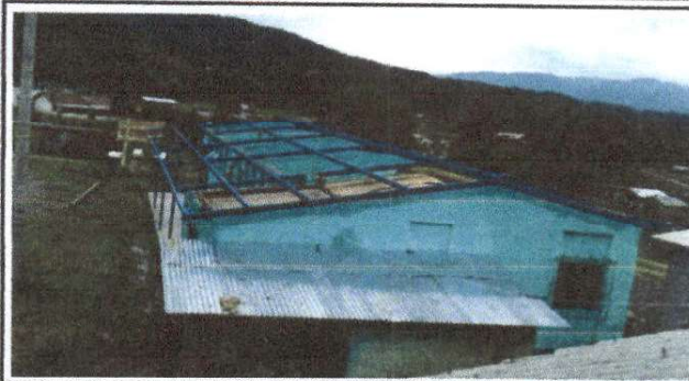
Foto 2: MANTENIMIENTO A ESTRUCTURA (LIJADO Y APLICACIÓN DE PINTURA) A COSTANERAS Y PUERTAS DE AULAS.
