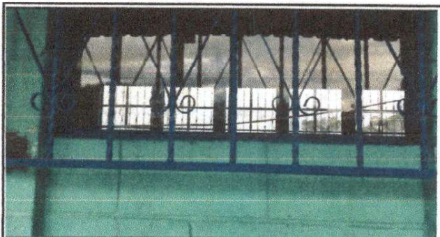
Foto 4: SUSTITUCION DE BALCONES DE METAL.
